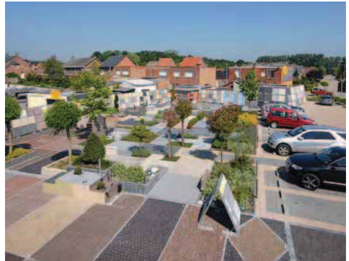
In het toonpark, naast de parking, ziet de bezoeker in één oogopslag hoe de klinkers er gelegd uitzien. Zo krijgt de klant een beter beeld van het eindresultaat
